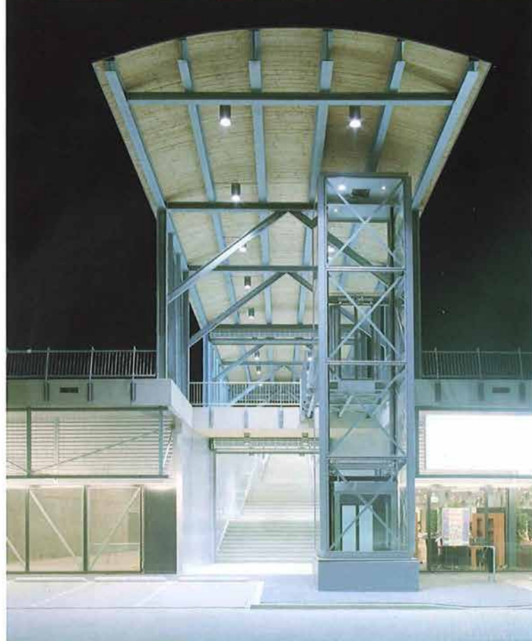
Project.....: Uitbreiding Woonboulevard te Heerlen Opdrachtgever.....: 3W Vastgoed Programma.....: Gebouw met 35.000m 2 winkelruimte Fotograaf.....: Philip Driessen Maastricht
