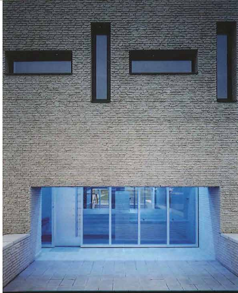
Project.....: Kantoor Janssen Precision Engineering te Beek Opdrachtgever.....: Janssen Precision Engineering Programma.....: Kantoorgebouw interieur en terreininrichting Fotograaf.....: Arjen Schmitz Maastricht
