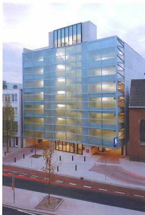
Project.....: Nieuwbouw Parkeergarage Putgraaf te Heerlen Opdrachtgever.....: Vastgoed Ontwikkelings Centrum B.V. Programma.....: Bouw parkeergarage met 300 plaatsen Fotograaf.....: Arjen Schmitz Maastricht
